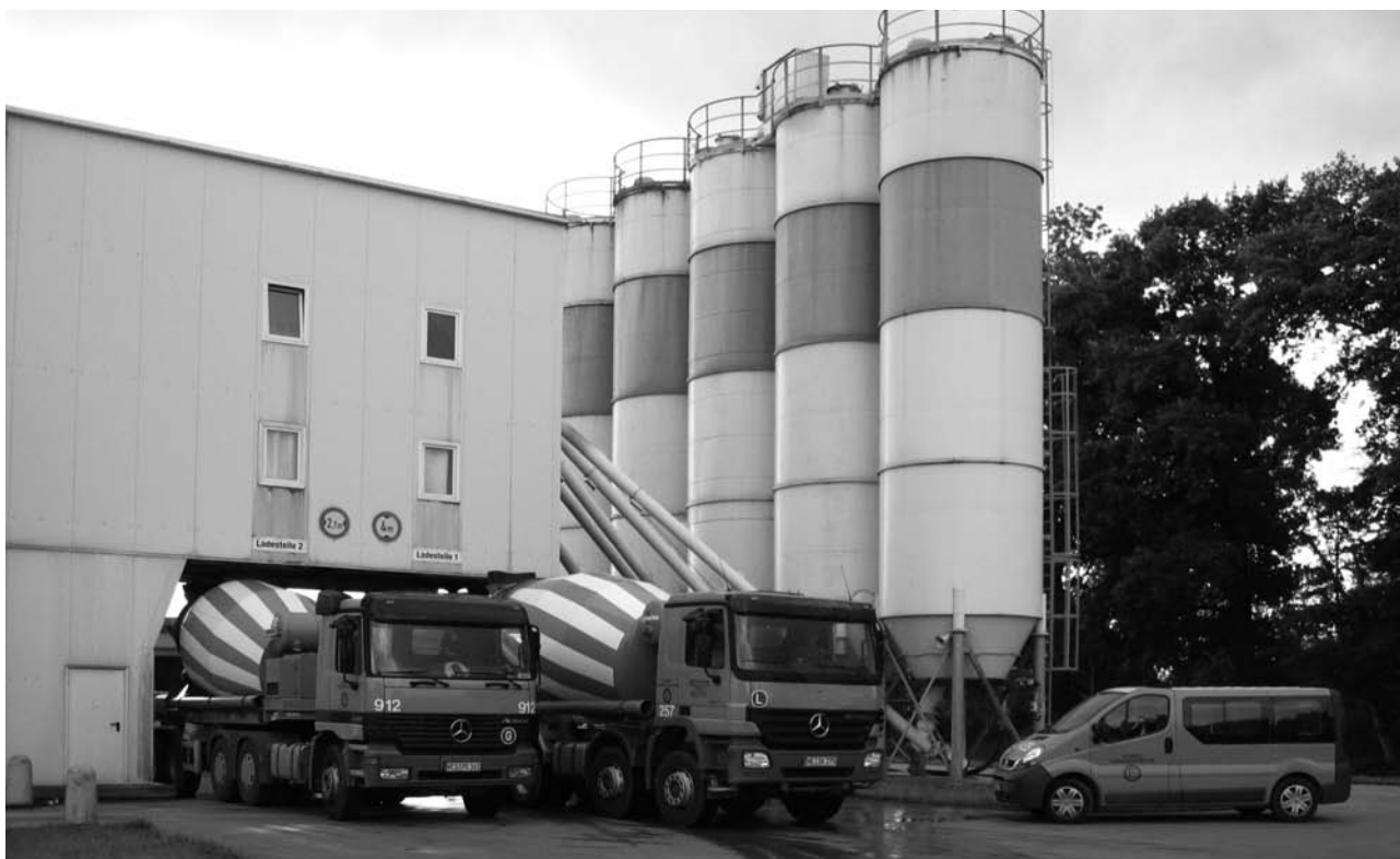
Bild 1: Lieferung von Transportbeton mit dem Fahrmischer
