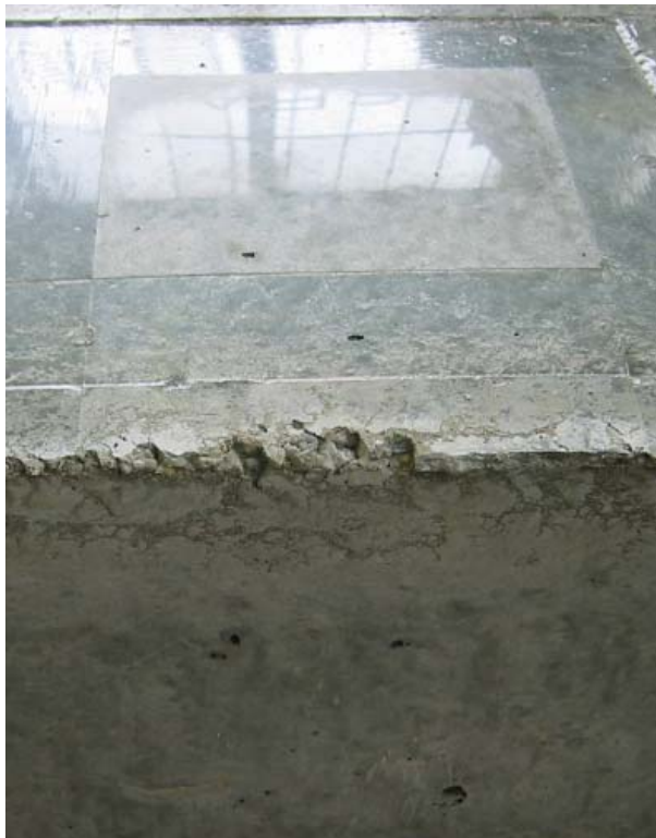
Bild 4.26 (links): Leimabsonderung infolge undichter Schalung bei Stütze 2b*
