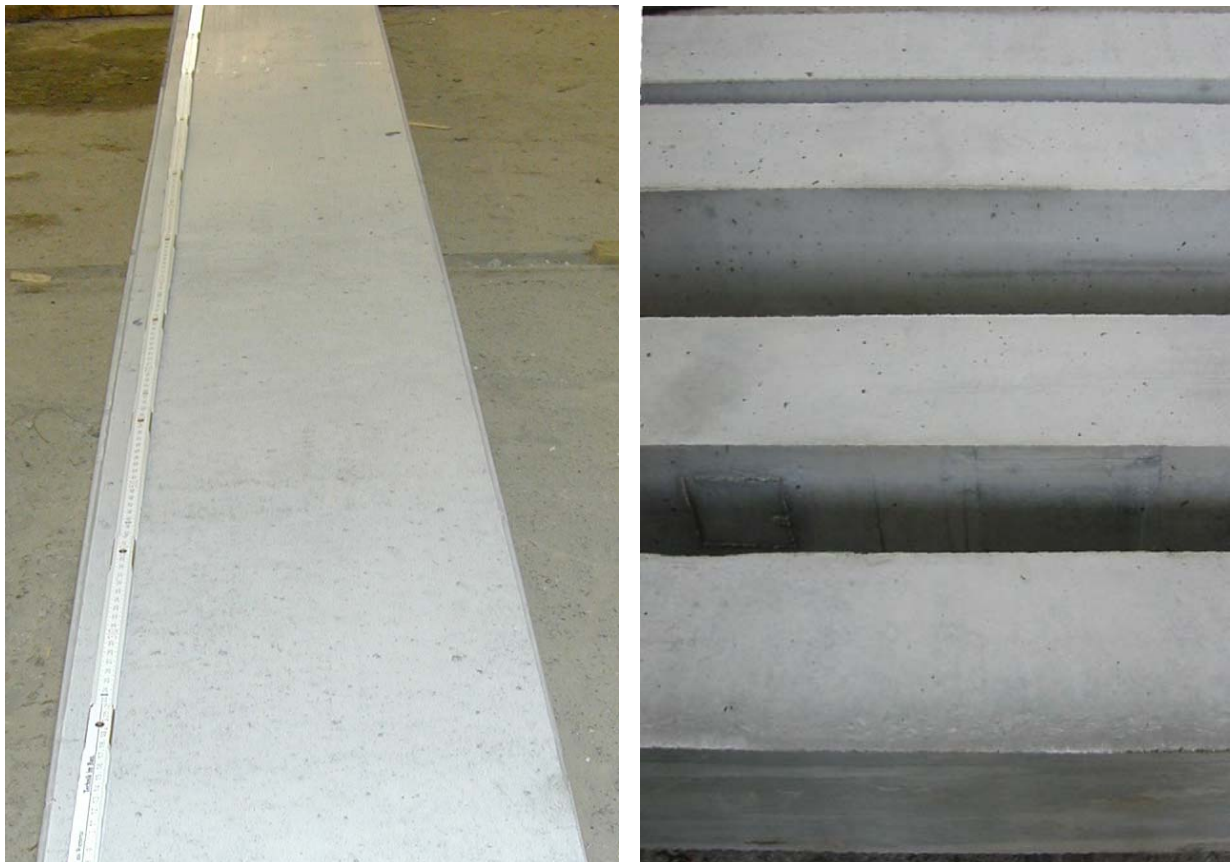
Bild 4.15: Stütze 5a, betoniert mit einer Geschwindigkeit von 160 m/h
